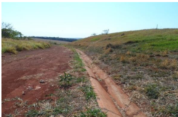
Figura 7: Canaletas externas de drenagem de água pluvial.
