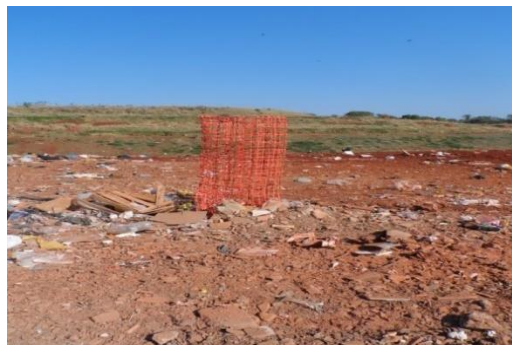
Figura 10: Saída dos gases gerados.
