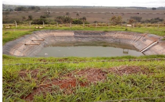
Figura 9: Lagoa facultativa de tratamento de chorume.
