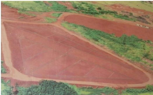
Figura 8: Canaletas internas de drenagem de chorume.
