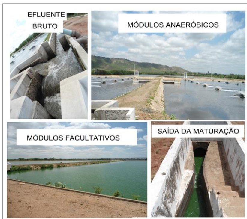
Figura 02: Visualização das etapas de tratamento do sistema de lagoas de estabilização do município de Juazeiro do Norte.
