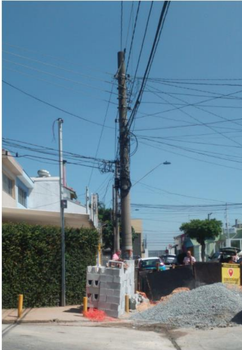
Figura 10: Poste para instalação dos painéis elétricos.
