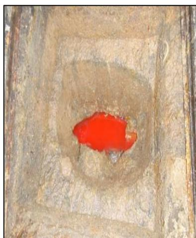
Figura 2 – Gordura incrustada na parede da caixa
