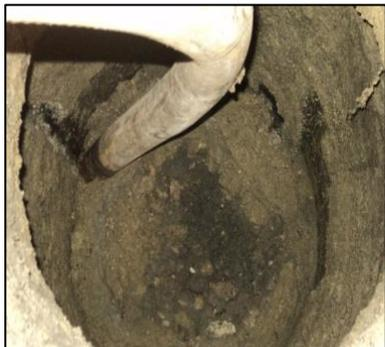
Figura 3 – Limpeza de PV.
