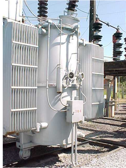
Figura 11: Novo transformador instalado
