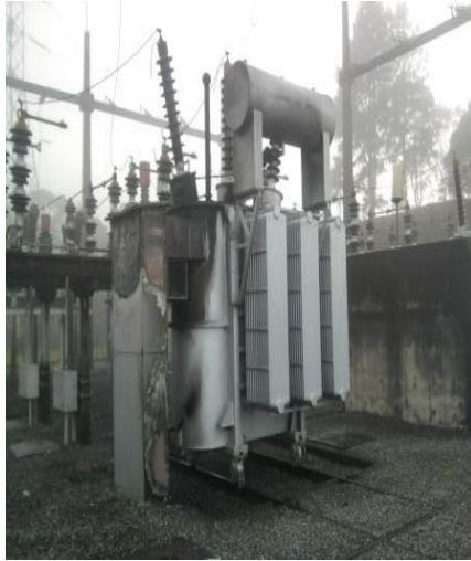
Figura 10: Transformador avariado
