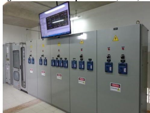
Figura 18: Relés Microprocessados (atuais)
