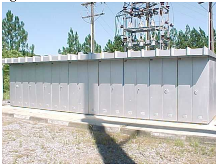
Figura 15: Painéis antes da cobertura
