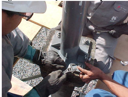
Figura 2: Instalação dos novos para-raios
