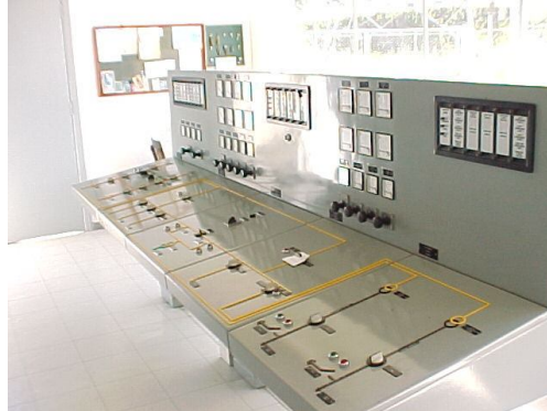
Figura 19: Antiga mesa de comando (painel sinóptico)
