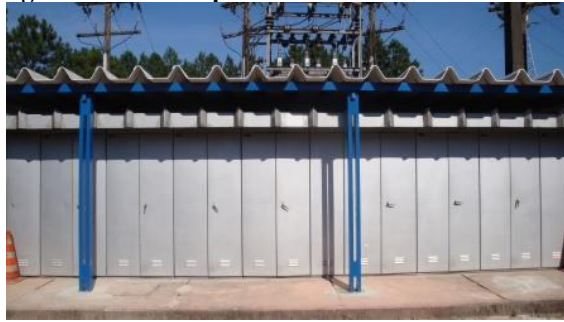
Figura 16: Painéis após a cobertura
