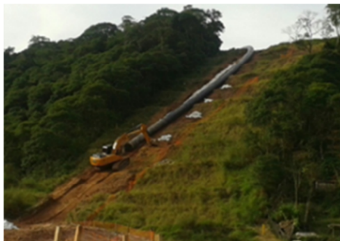
Figura 21: Assentamento da adutora em talude com grande inclinação.
