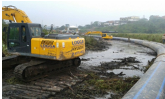
Figura 20: Montagem de tubulação em PEAD em terreno pantanoso.
