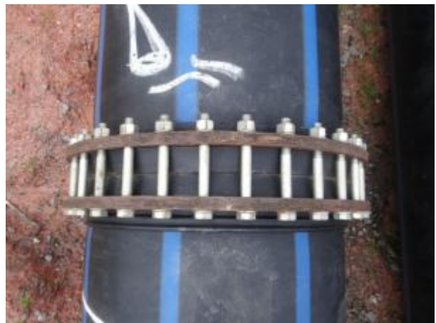
Figura 14: União de Tubos (Colarinho + Flange)
