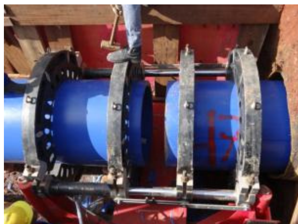
Figura 7: Execução Solda de Termofusão
