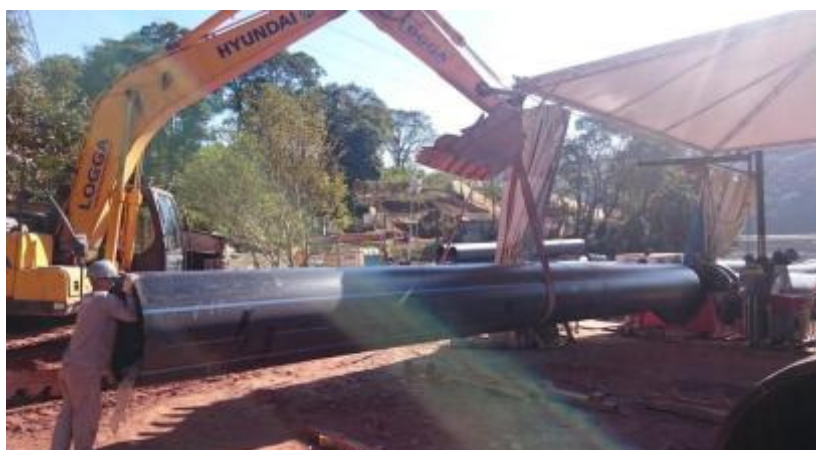
Figura 17: Alimentação da máquina de soldagem de tubos em PEAD.
