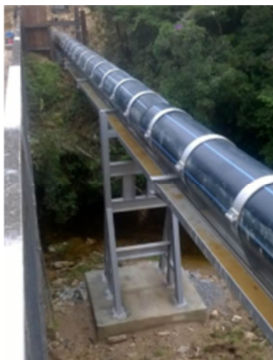
Figura 34: Travessia aérea de uma tubulação em PEAD.
