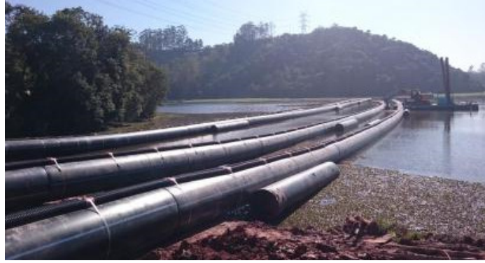
Figura 19: Esquema de montagem de tubulação em PEAD sobre a água.
