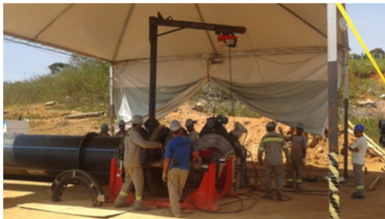
Figura 15: Máquina de soldagem de tubo em PEAD pelo processo de termofusão.
