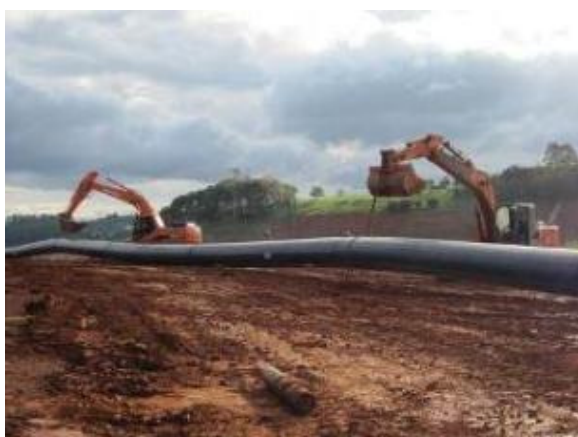
Figura 16: Movimentação de um tramo de tubulação em PEAD com máquinas escavadeiras.
