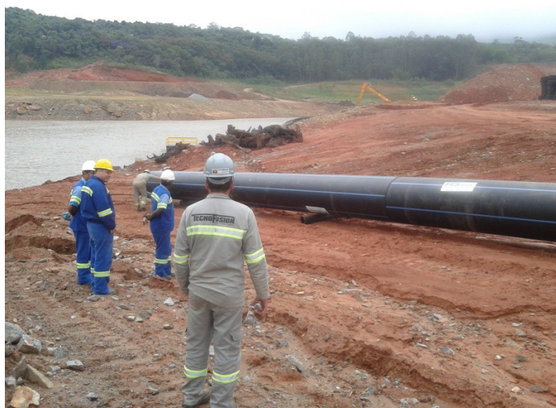
Figura 18: Após a soldagem, movimentação dos tubos em PEAD em direção ao corpo d'água.
