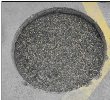
Camada de 3 cm de espessura de cascalho lavado (tamanho 4 - 8 mm).
