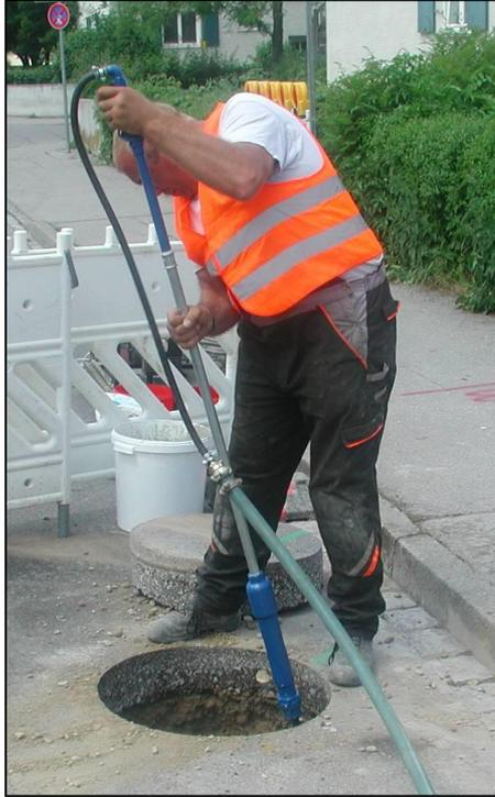
O poço de acesso é preenchido novamente e compactado em camadas. Dependendo das condições do solo, o material escavado pode ser reutilizado.
