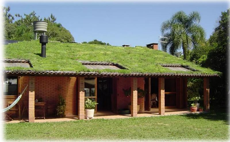
Casa com utilização de material sustentável: telhado verde e painel fotovoltaico
