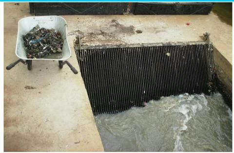
Os dejetos se acumulam, trancam o fluxo do esgoto e ocasionando extravasamentos em pontos mais baixos da rede ou até mesmo o refluxo do esgoto para dentro dos imóveis.
