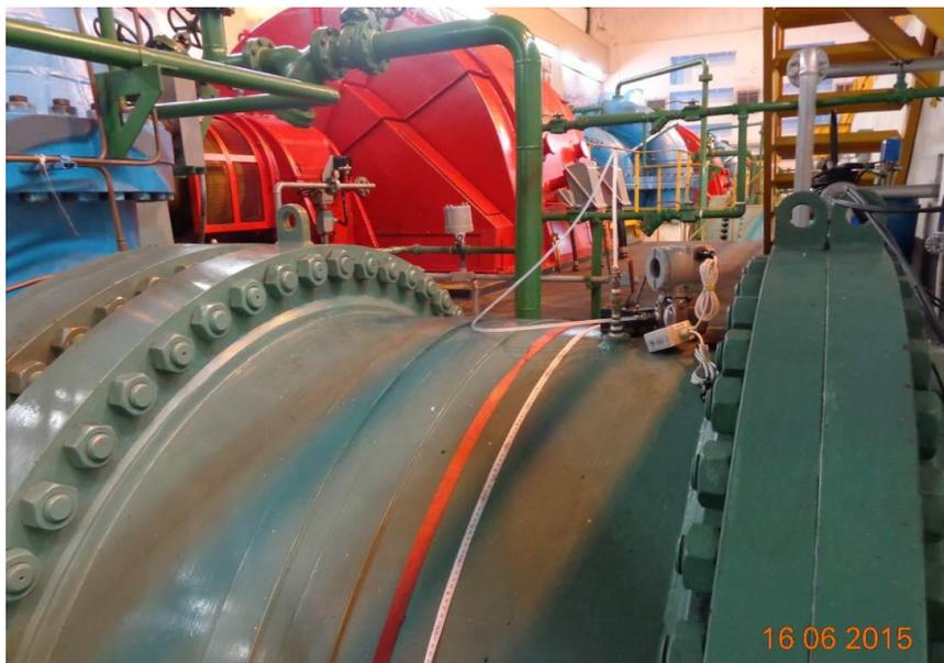
foto 04 – transdutor de pressão instalado na sucção do grupo moto bomba n.º 01
