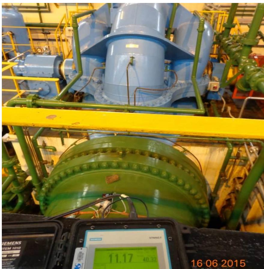
**Foto 03 – medidor de vazão instalado no grupo moto bomba n.º 01**
