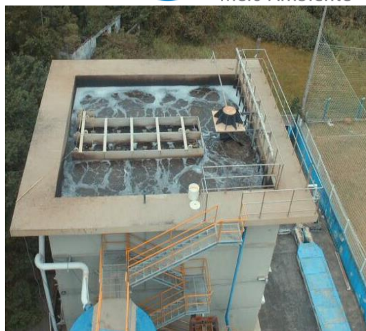
Figura 1: (a) Vista superior do Reator UBOX®, (b) Concepção do Reator UBOX®. Fonte: (a) Autor (2017). (b) Adaptado de Astrasand (2017).
