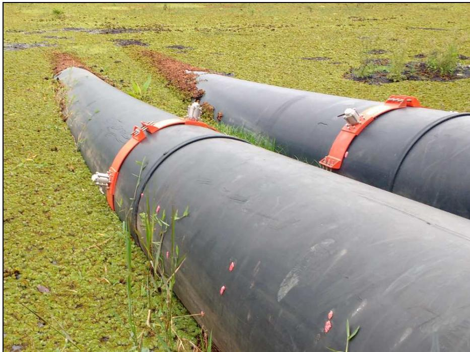
Foto 02 - detalhe das válvulas das abraçadeiras
