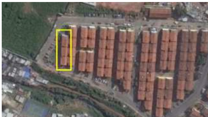
Figura 15 – Conjunto Habitacional Vitória
