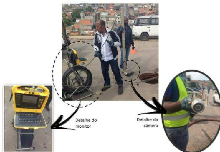
Figura 17 – Monitoramento da rede de esgoto
