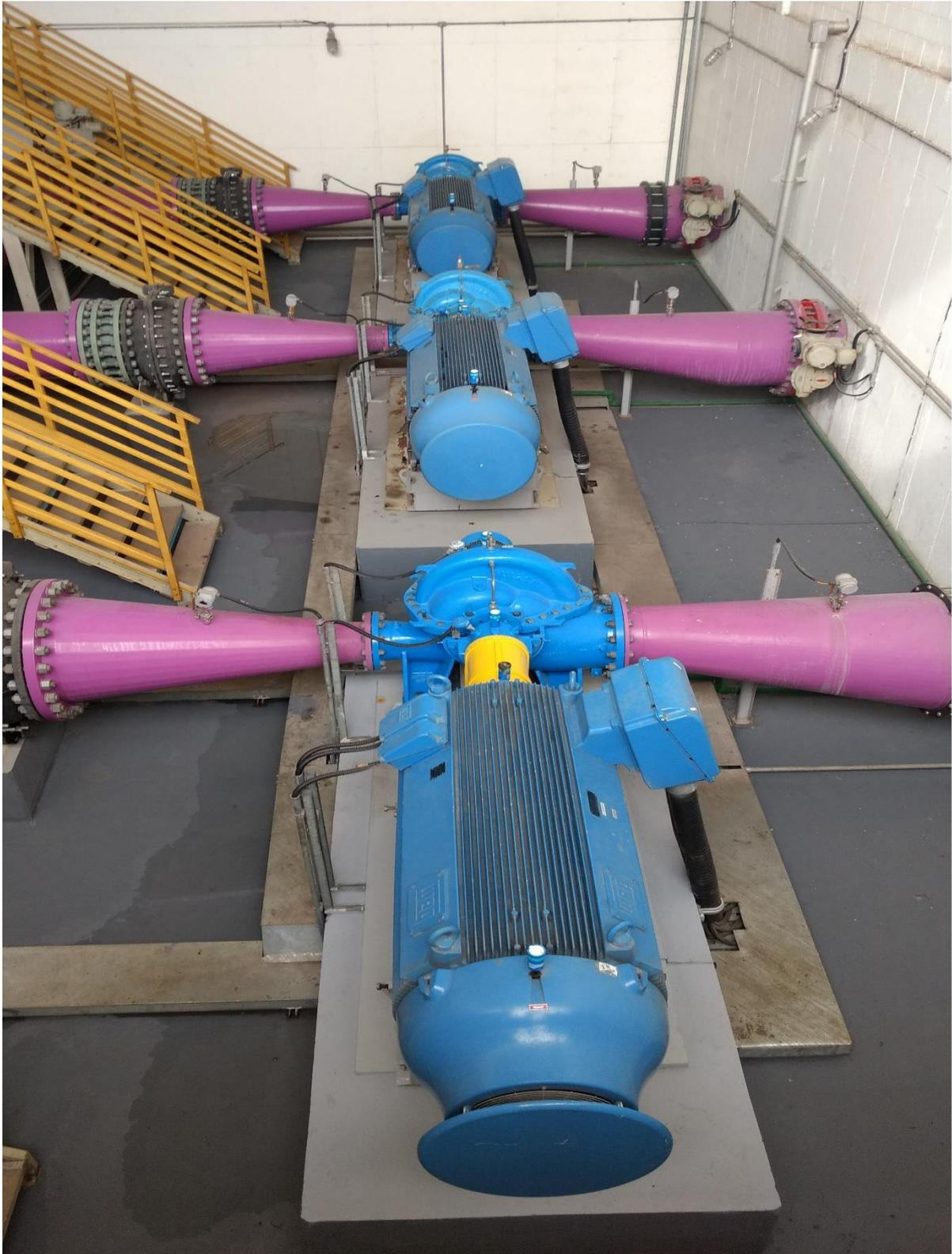
**Figura 2 – Disposição das bombas A, B, C na Estação Elevatória de Alta Carga**
