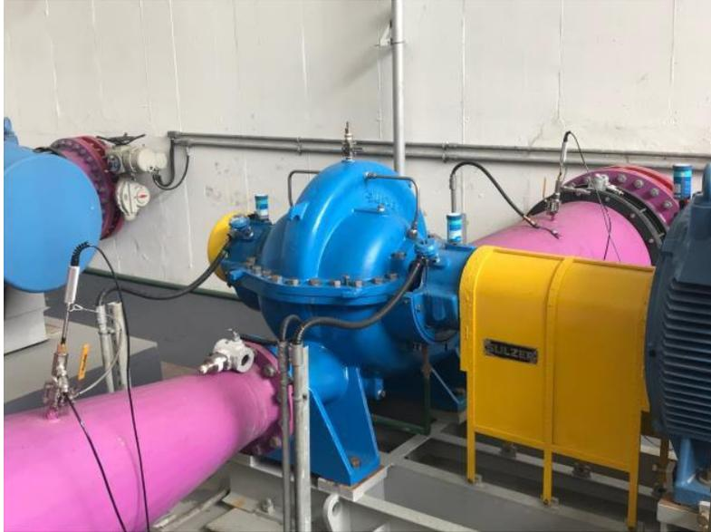
**Figura 5 – Conjunto motobomba e sensores instalados na sucção e recalque**
