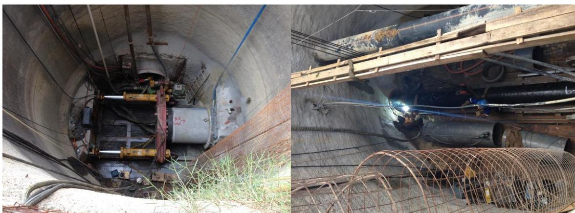
**Figura 2. Cravação de tubos de concreto e tubos de aço. Fonte: Autor.**
