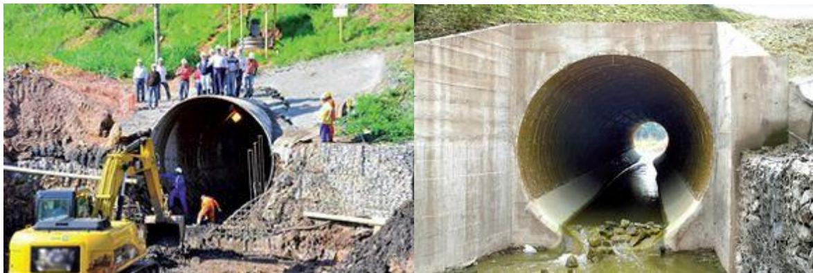
**Figura 4. Tubulações executadas através do método *Tunnel Liner*. Fonte: (Nakamura 2012).**
