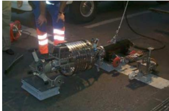
Figura 3 - Robô para lançamento da estrutura de fibra óptica
