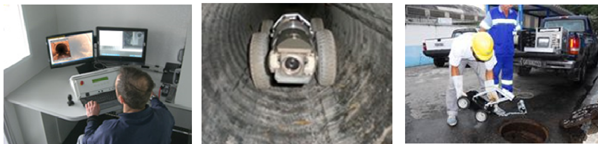
Figura 3- Inspeção de linhas de esgoto com a utilização da tecnologia de filmagem robotizada com circuito fechado de televisão
