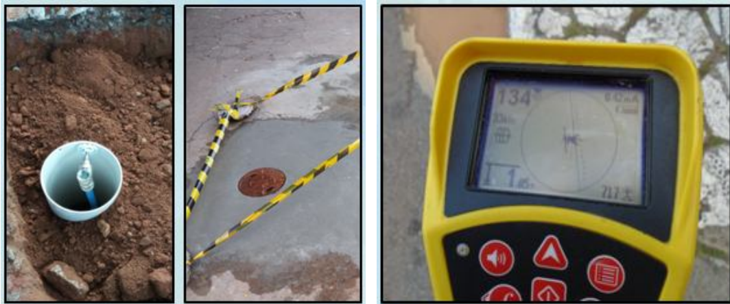
Figuras 5 e 6: Construção de acesso para monitoramento do ponto crítico
