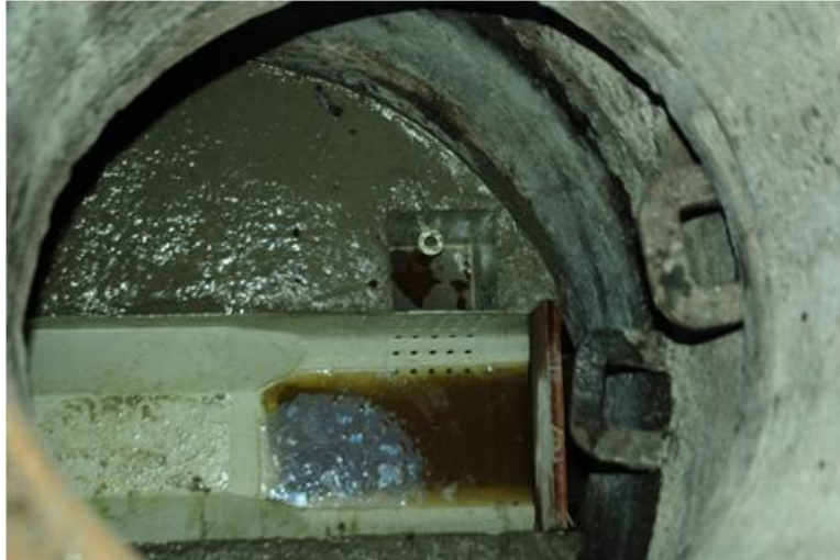
Figura 1: Calha Palmer Bowlus instalada em um Poço de Visita a jusante da bacia em estudo.
