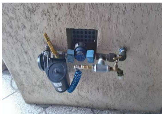
Figura 4: Sensor de pressão do ponto crítico alto
