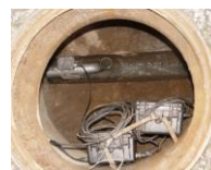
Fig. 9 e 10 - Medidor eletromagnético de passagem plena inserível nas tubulações através dos PVs Fonte: Arquivo do autor
