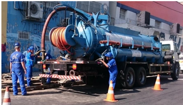
Fig. 13: Manutenção preventiva em rede coletora com emprego de equipamento combinado hidrojato e vácuo.
