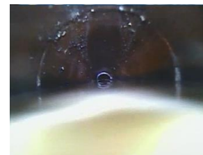
Fig. 8 - Trecho com deflexão, a câmera mergulha em um e retorna no próximo. Fonte: Arquivo do autor
