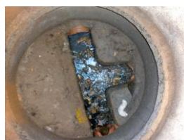
Fig.12 – Trecho com velocidade baixa facilitando a sedimentação
