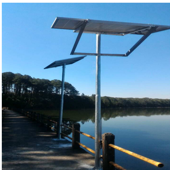
Figura 3: Instalação e posicionamento das placas solares na Barragem Pedro Beicht.
