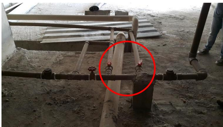
**Figura 2 – Ponto de ligação cruzada dos reservatórios de água potável e água de chuva.**
