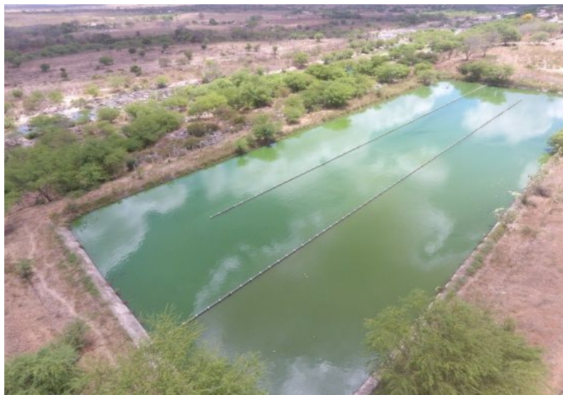
Figura 2: Vista superior da Estação de Tratamento de Esgotos do município de Santana do Ipanema - AL
