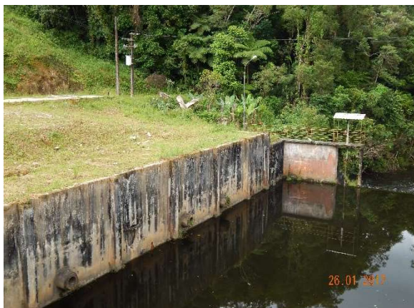
Foto 9: Barragem KM 78 do sistema Rio Claro, estrutura em destaque muro de aproximação.
