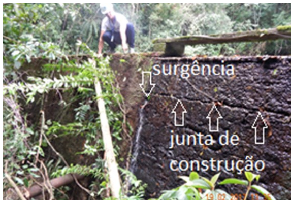
Foto 10: Barragem do Mato do Sistema Aldeia da Serra em destaque paramento de jusante.
