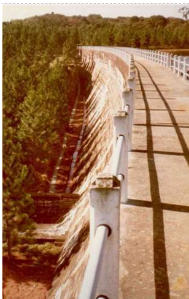
Foto 5: barragem Pedro Beicht do Sistema Alto Cotia. Barragem em arco.
