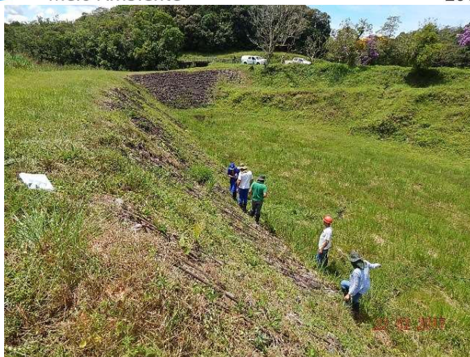
Foto 3: barragem Poço Preto do Sistema Rio Claro – inspeção realizada pelos próprios técnicos da Sabesp, sendo a barragem avaliada pelo Índice de Comportamento – IC.
