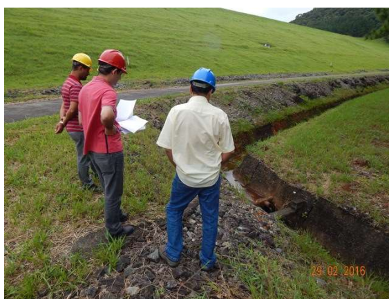
Foto 1: Barragem Jaguari do Sistema Cantareira – barragem federal – inspeção realizada pelos técnicos da ANA – Agência Nacional das Águas acompanhados pelos técnicos da Sabesp.
