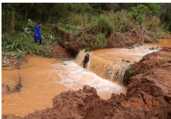
Foto 11: Barragem Terra Preta do Sistema isolado em destaque vista geral da barragem.
