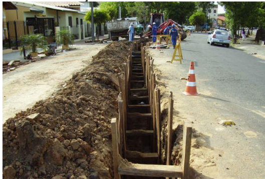
Figura 14 - Vala a céu aberto para assentamento de rede com escoramento. Fonte: Cosatel
