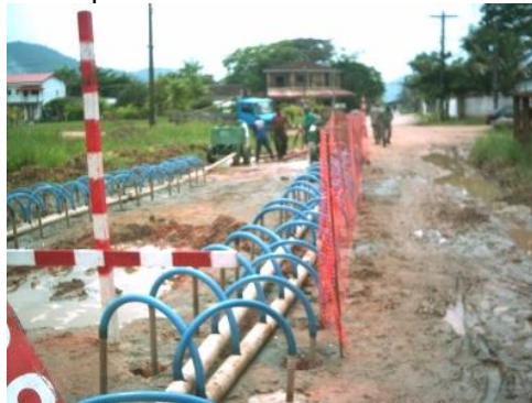
Figura 15 - Uso de rebaixamento de lençol freático. Fonte: Rimenco
