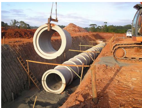
Figura 10 - Assentamento de tubo de concreto. Fonte: AECweb
