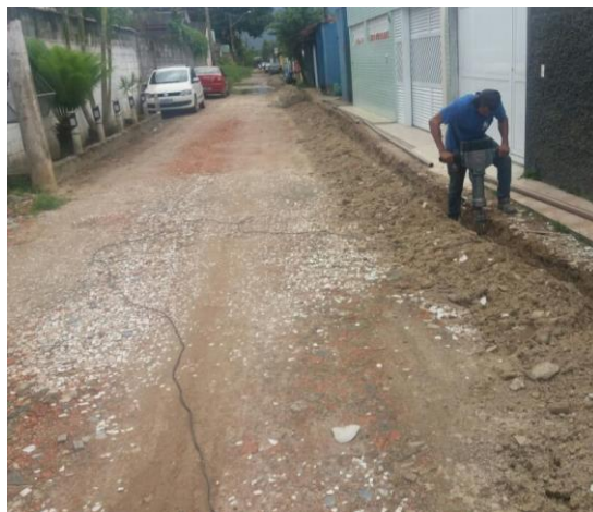
Figura 11 - Assentamento rede de água. Fonte: Arquivo Pessoal 21/01/2016
