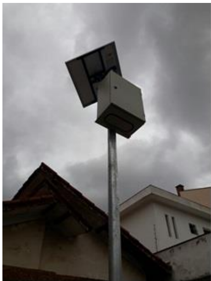
Figuras 2 e 3 –Painel Solar Bateria, controlador e disjuntor
