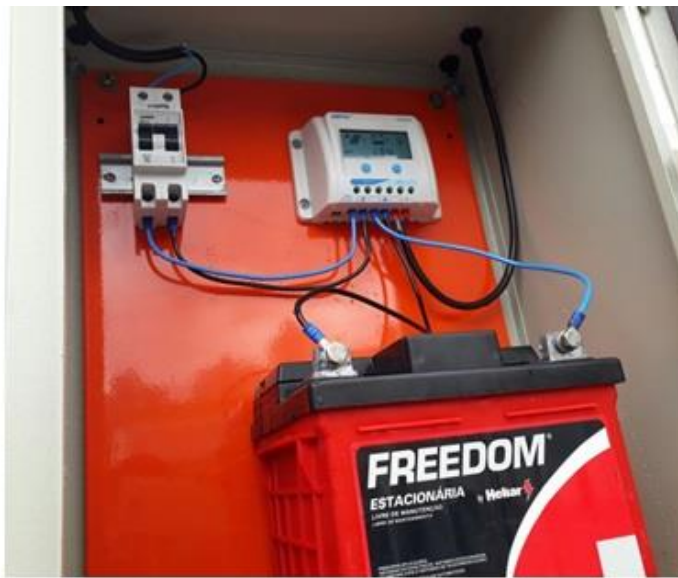
Figuras 2 e 3 –Painel Solar Bateria, controlador e disjuntor
