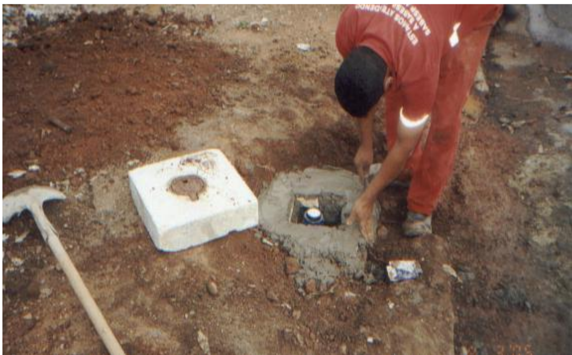
Figura 05: Construção e proteção do Macromedidor em Comunidade.
