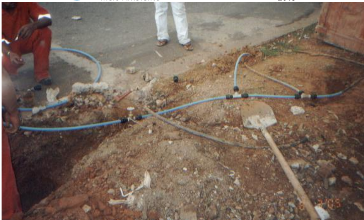
Figura 04: Adequação e preservação das ligações irregulares para instalação de Macromedidor.
