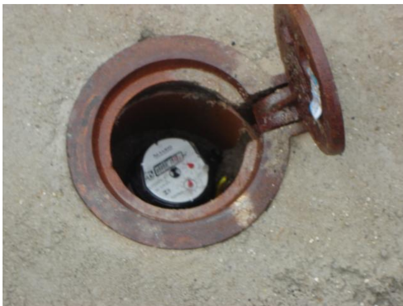
Figura 06: Detalhe da Construção e proteção do Macromedidor em Comunidade.
