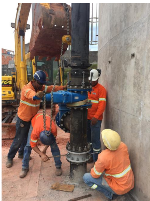
Figuras 7 e 8: Montagem da Interligação do Reservatório Mirante Jandira
