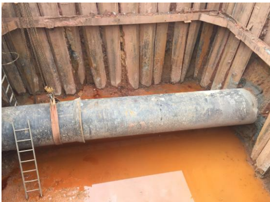
Figuras 16 e 17: Estudo da suportação provisória da adutora de Carapicuíba
