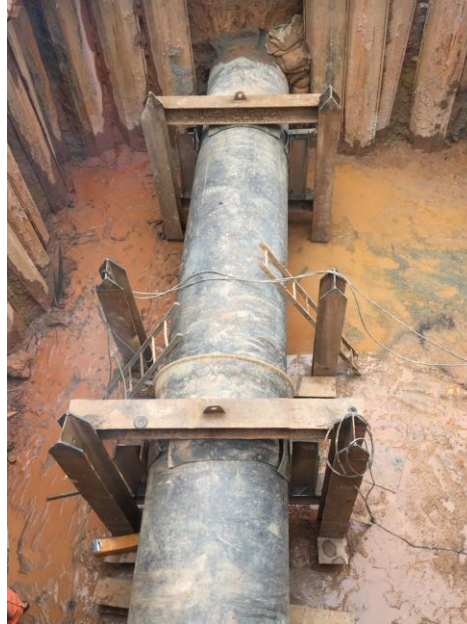
Figura 18: Suportação provisória da adutora de Carapicuíba
