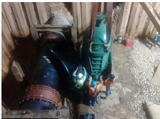
Figura 20: Montagem da Válvula Gaveta na adutora de Carapicuíba
