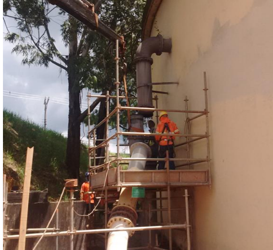
Figura 11: Montagem da interligação do Reservatório Jardim Tupã
