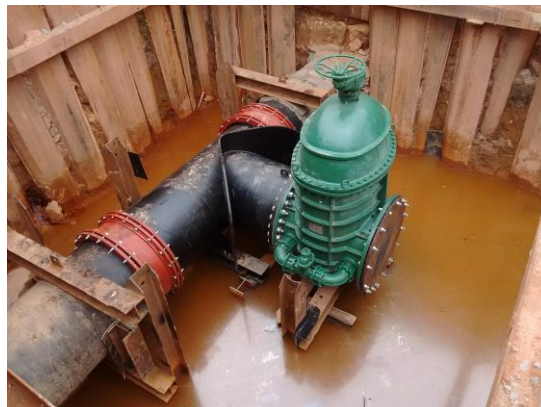
Figura 20: Montagem da Válvula Gaveta na adutora de Carapicuíba
