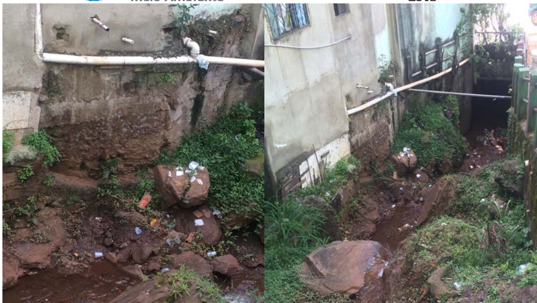
Figura 6 – Focos de Despejo de Águas Residuárias no Córrego Acaba Mundo
