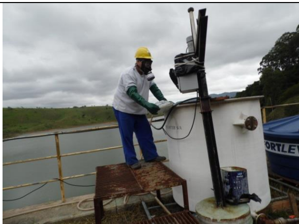
Figura 4: Dissolução e mistura do Sulfato de cobre.
