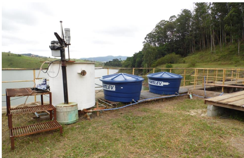
Figura 3: Sistema de Aplicação de Algicidas no emboque do Túnel 6 (Reservatório Cachoeira).
