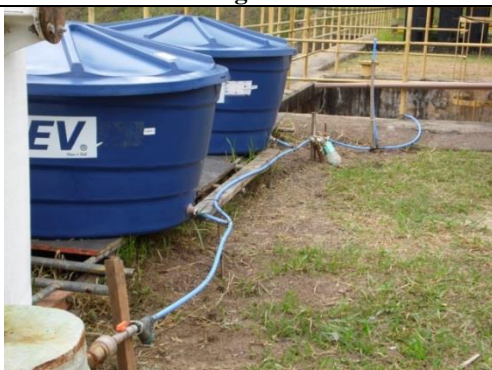
Figura 8: Mangueira de PEAD para aplicação de algicidas.
