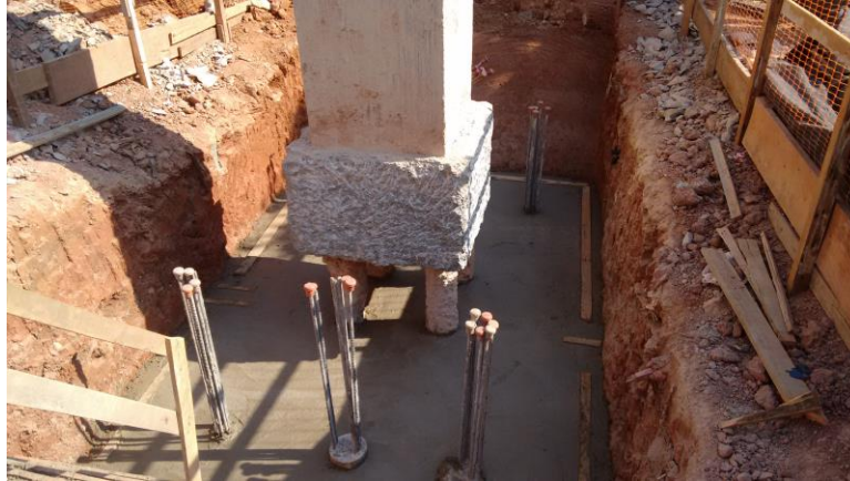
Figura 06: Execução do reforço estrutural nos apoios.
