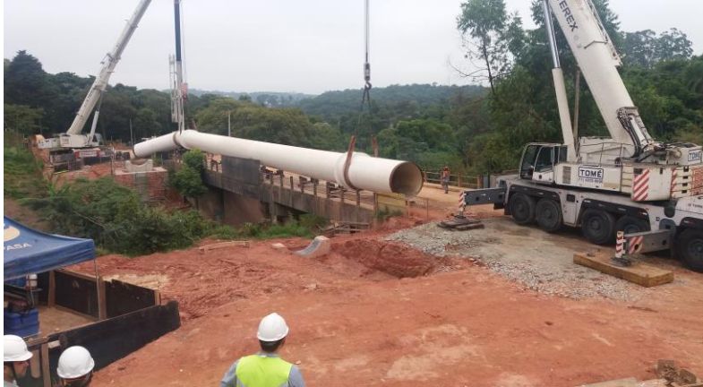
Figura 03: Guindastes para içamento do tubo
