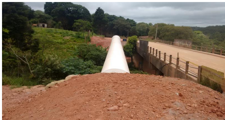
Figura 04: Adutora ao lado do viaduto sobre a ferrovia
