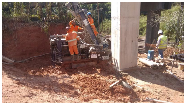
Figura 05- Pilar do apoio 02 executado
