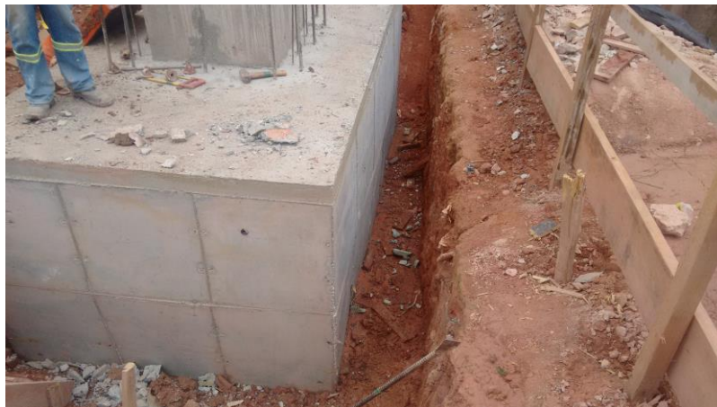
Figura 07: Reforço estrutural finalizado no apoio.
