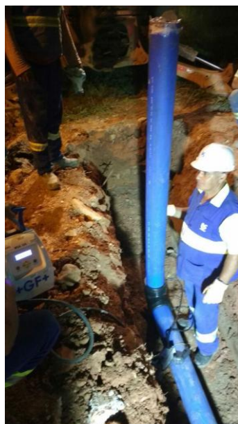
Montagem da montante e jusante da VRP
