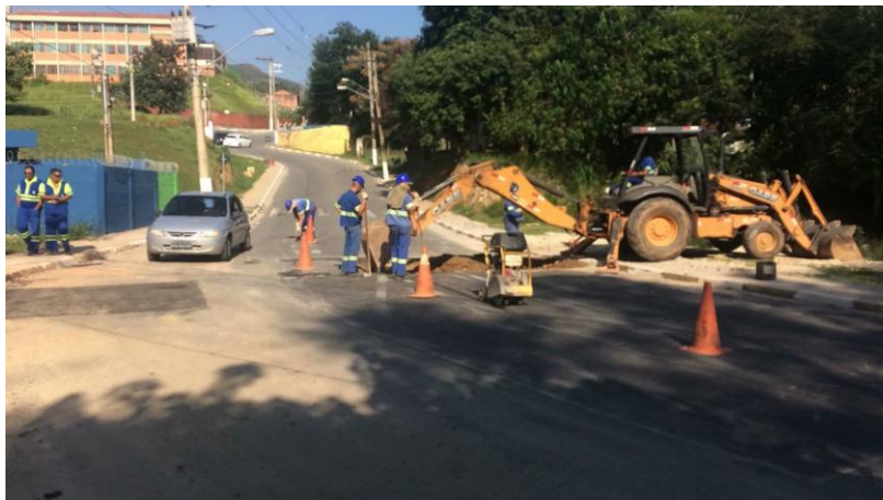
Início da escavação
