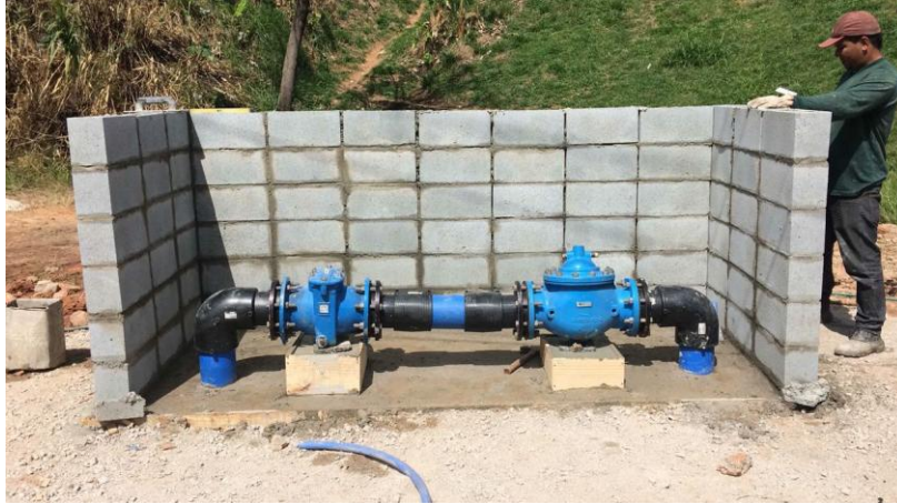
Construção das paredes do Abrigo
