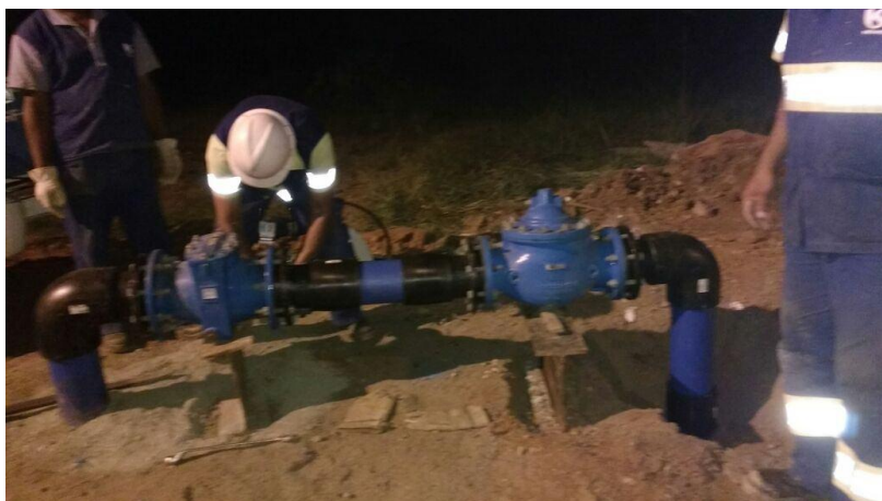
Montagem do conjunto da VRP
