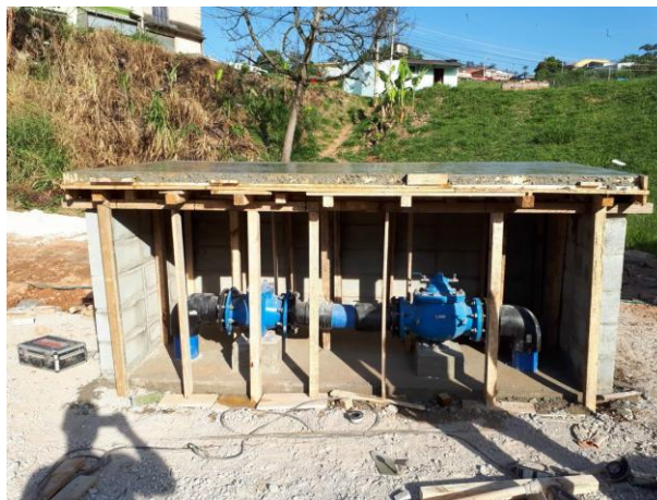
Confecção da laje do Abrigo
