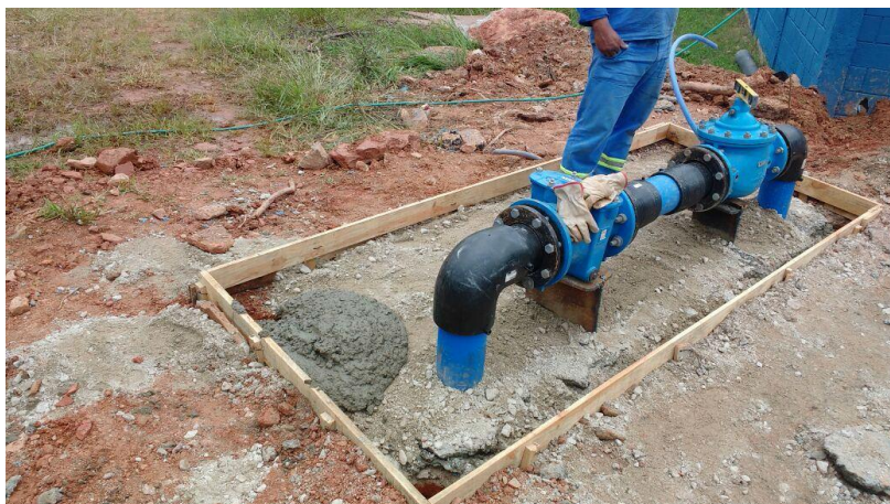
Execução da base do abrigo da VRP
