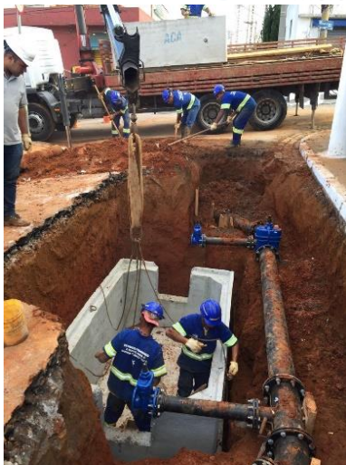
Descida das aduelas
