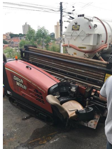
Máquina executora dos serviços, junto a vala 2
