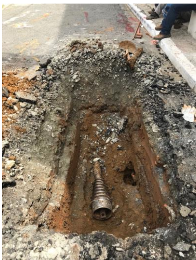
Vala 1, peça conectora na rede nova
