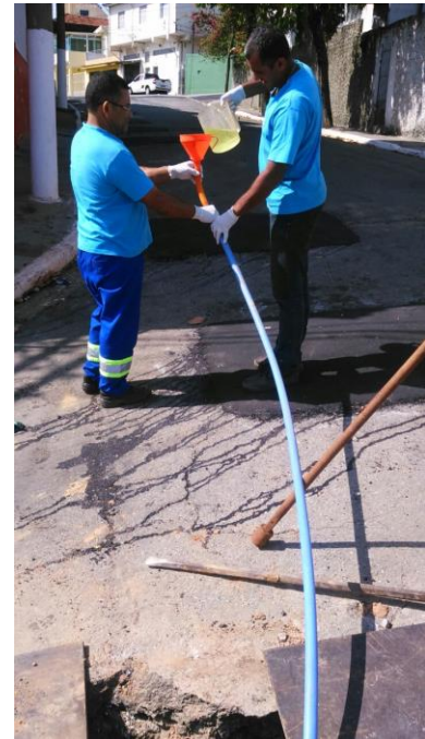
Cloração da rede nova substituída
