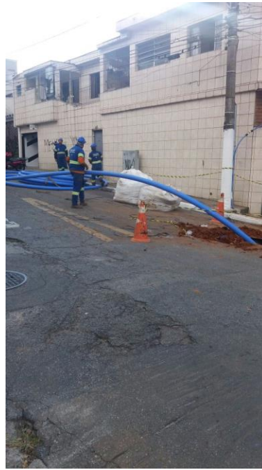
Vala onde o tubo novo é puxado
