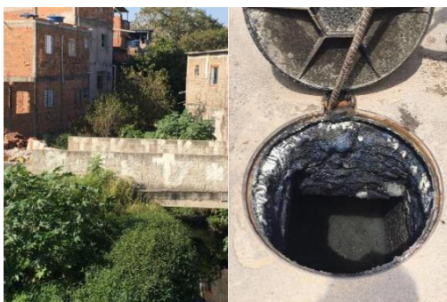
Figura 1. Lançamento clandestino de esgoto no Canal de Circunvalação (à esquerda) e na rede de drenagem existente (à direita)
