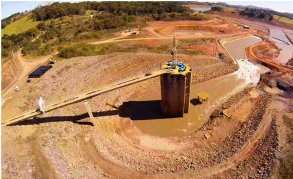
Figura 2 - Reservatórios do Cantareira captando água do volume morto (set/2014)
