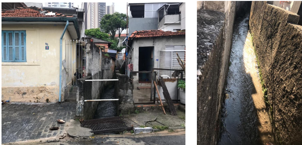
Figura 1: canaleta de água pluvial
