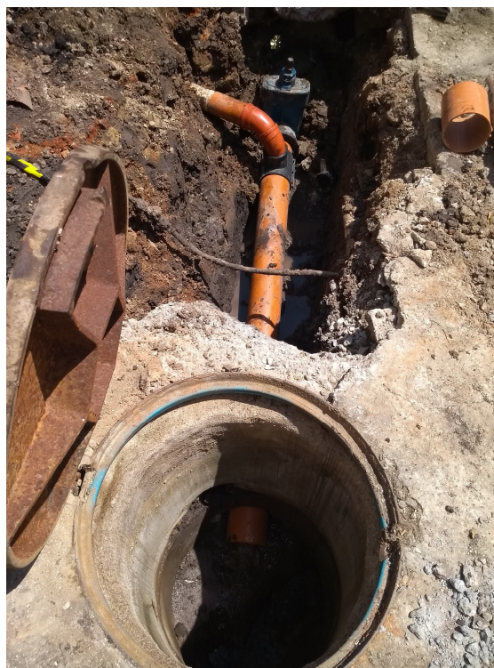
Figura 4: Válvula de gaveta com graduação do fluxo de esgoto
