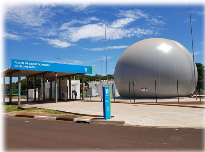
Figura 10 - Posto de Beneficiamento do Biogás e Produção de Biometano.
