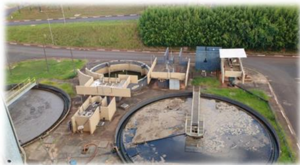
Figura 5 - Vista dos Adensadores Por Gravidade.
