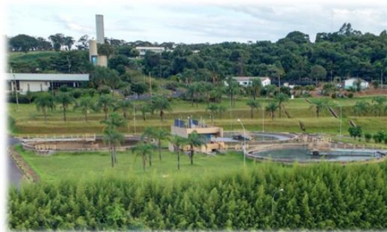
Figura 4 - Vista dos Decantadores Primários.
