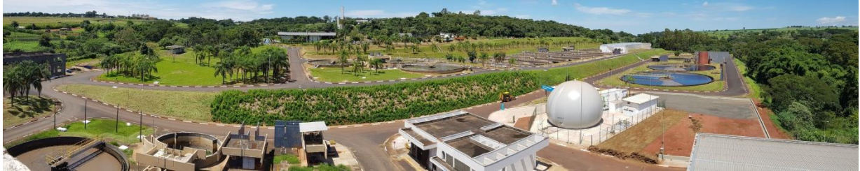
Figura 1 - Vista panorâmica da ETE Franca.
