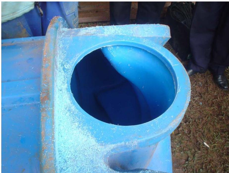
Figura 15: Furo para instalação da junta flexível.
