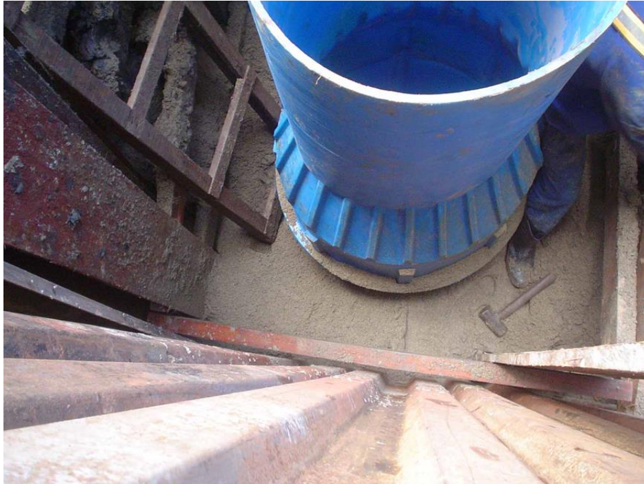
Figura 5: Escoramento e berço de arcia.
