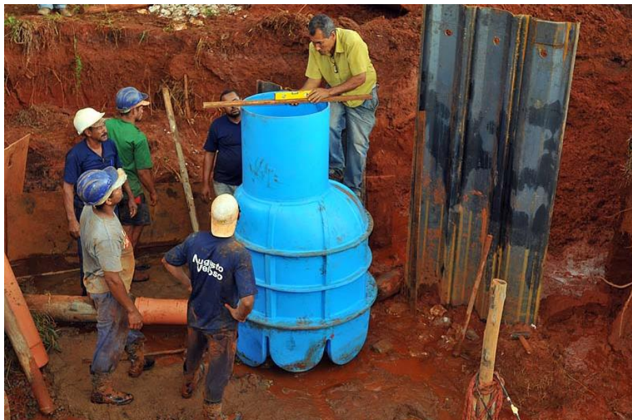
Figura 8: Nivelamento do PV em material plástico.
