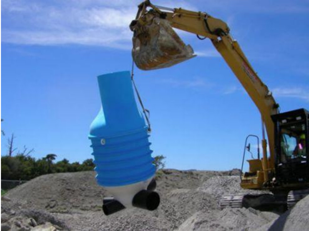
Figura 2: Manuseio com o auxílio de retroescavadeira.
