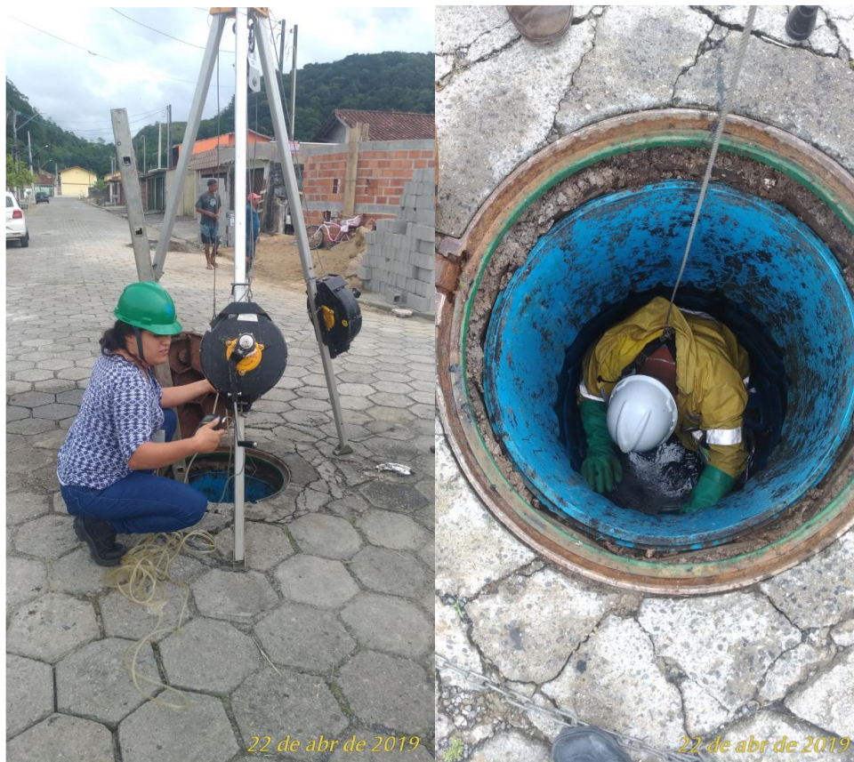
Figura 23: Teste de entrada em PV DN 800.
