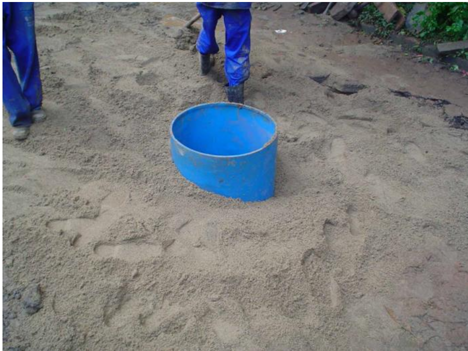
Figura 10: Adensamento com areia.
