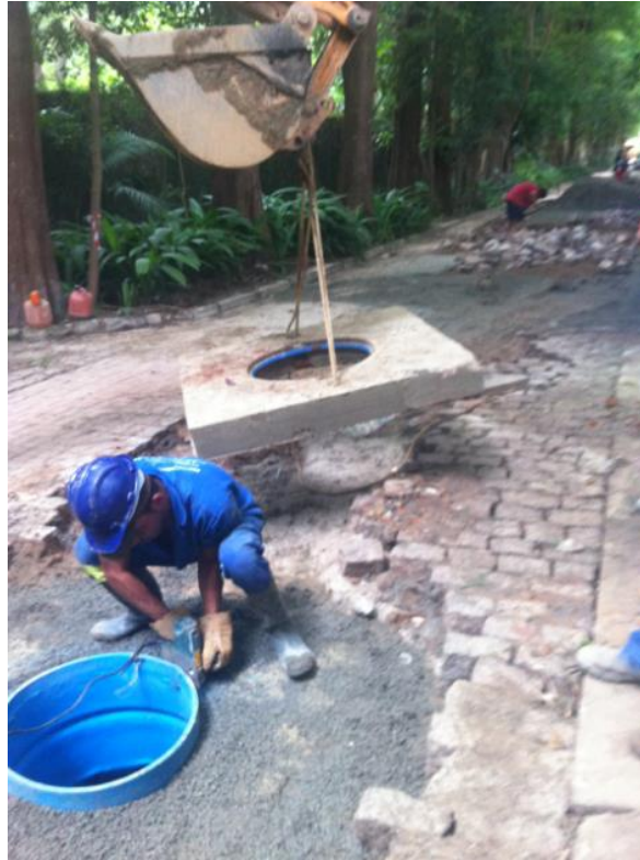
Figura 11: Montagem da laje pré-moldada.
