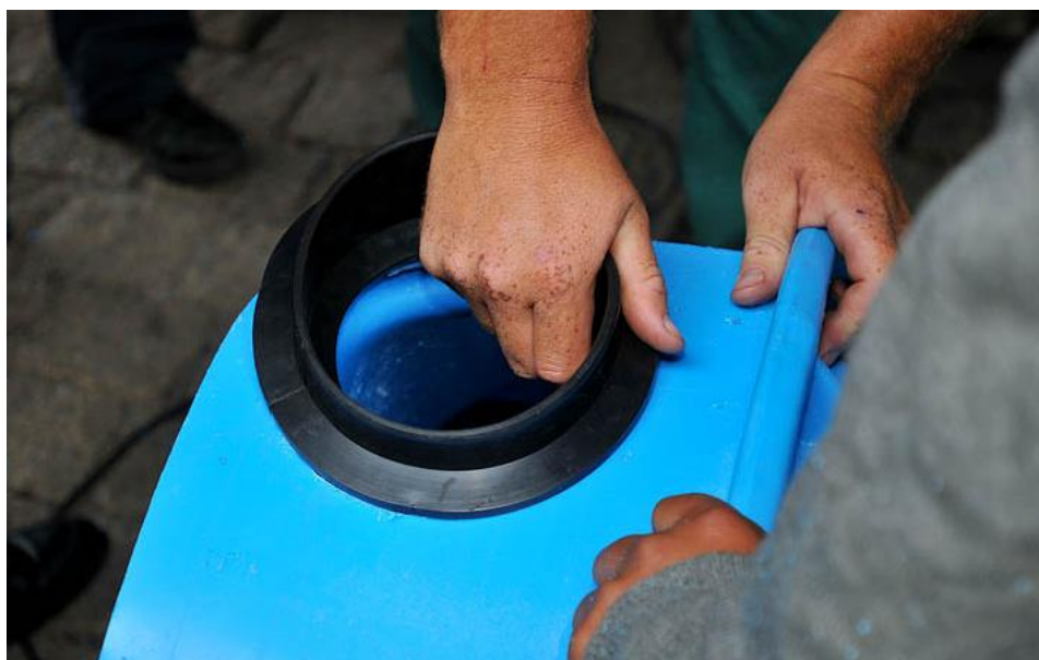
Figura 16: Instalação da junta flexível.
