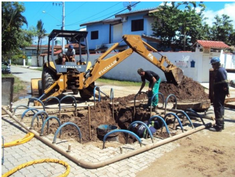
Figura 6: Rebaixamento de lençol freático
