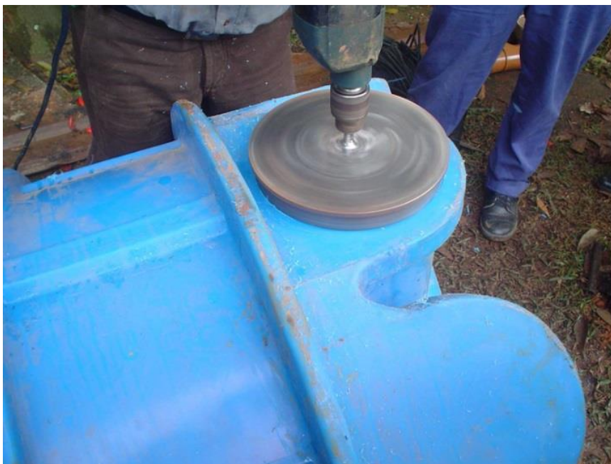
Figura 14: Execução de furo para instalação da junta flexível.
