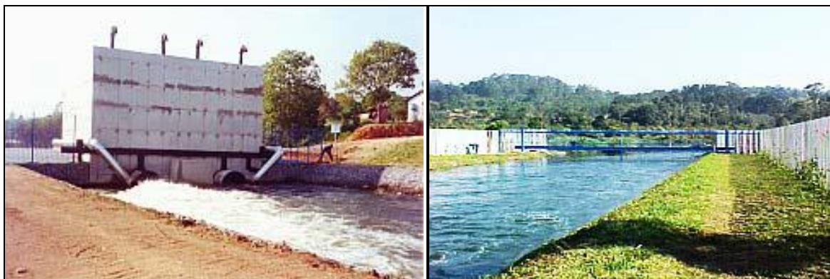
Figura 5 e 6: Caixa de dissipação e canal de chegada d'água na várzea do reservatório Guarapiranga
