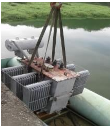
Figura 11, 12 e 13: Montagem da flange , transformador e tubulação recalque
