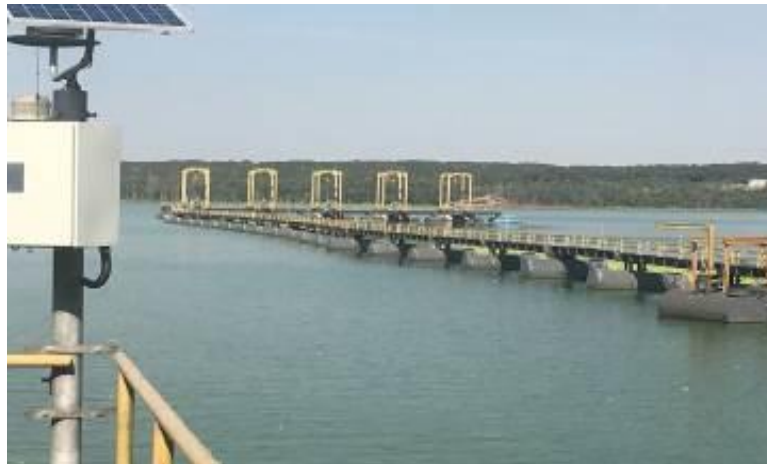
Figura 10: Vista Geral captação Flutuante e passarela acesso
