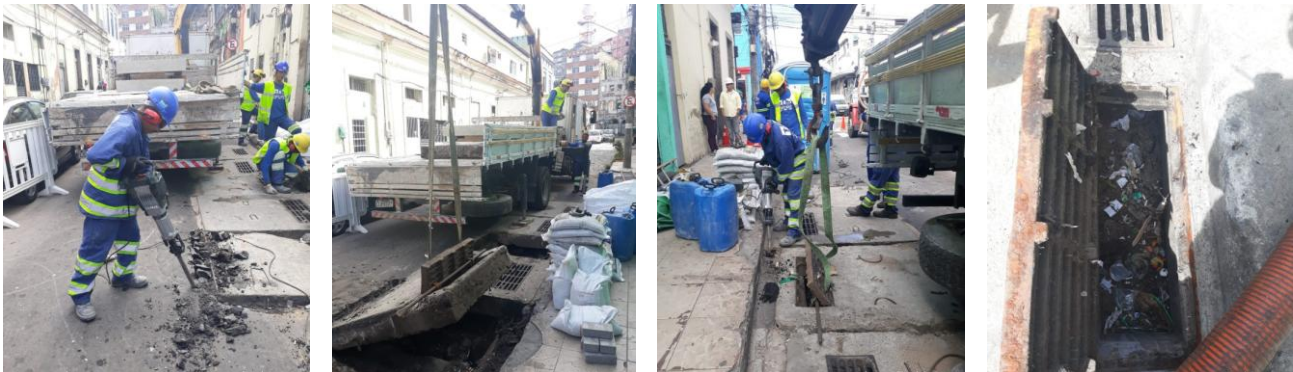
Figura 11 - Operação para abertura das caixas de sedimentos na Rua Costa Ferreira
