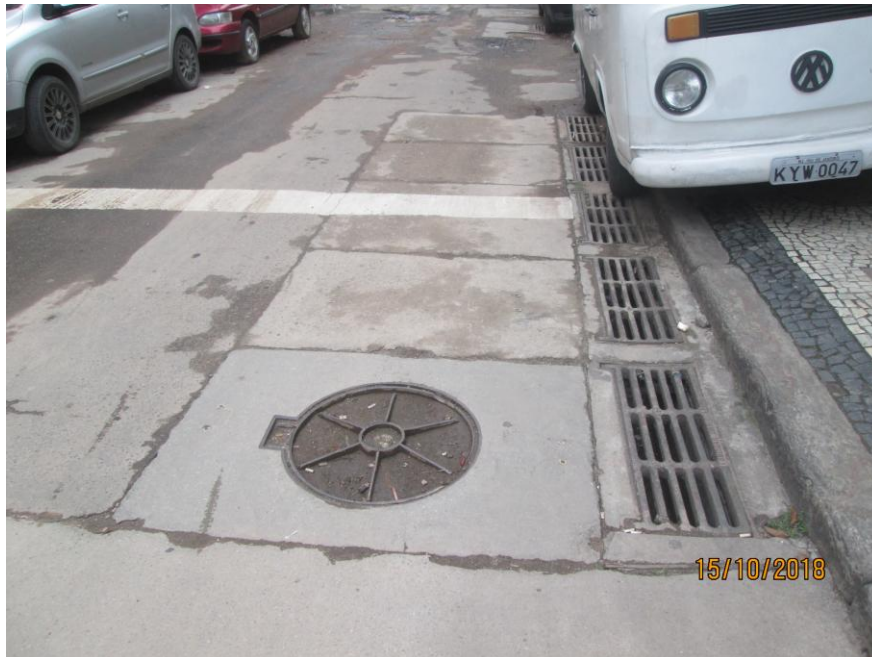
Figura 6 - Caixa de retenção de sedimento construída na Rua Visconde da Gávea, esquina com Barão de São Félix (ponto 1)
