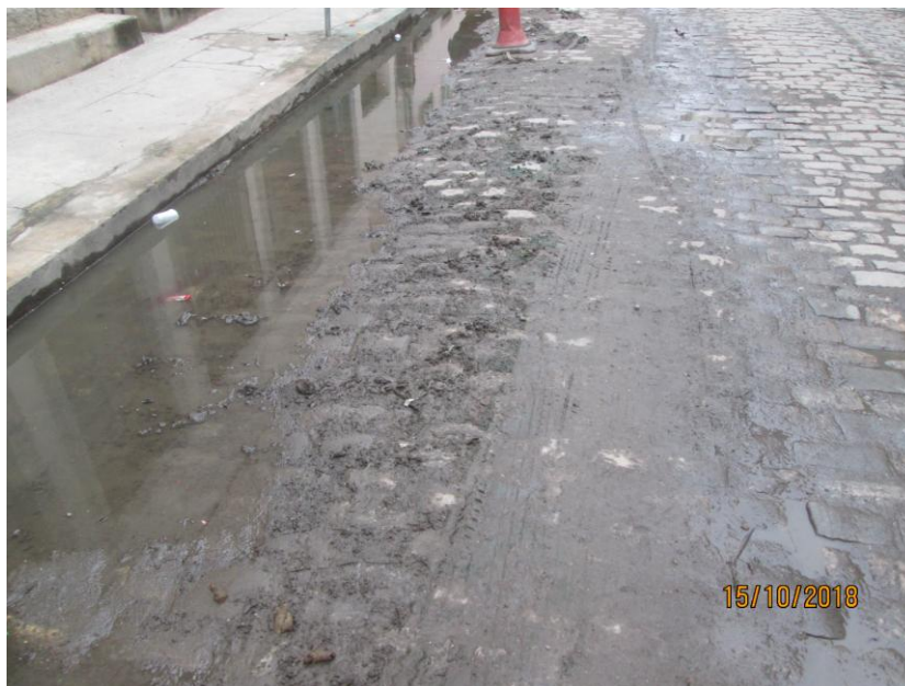
Figura 4 - Cruzamento entre Rua Visconde da Gávea e Rua Costa Ferreira (Próximo ao ponto 8) Fonte: Acervo próprio.
