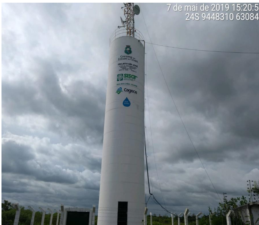
Figura 1: Reservatório do sistema de abastecimento de água de Serra dos Vieiras – Russas.
