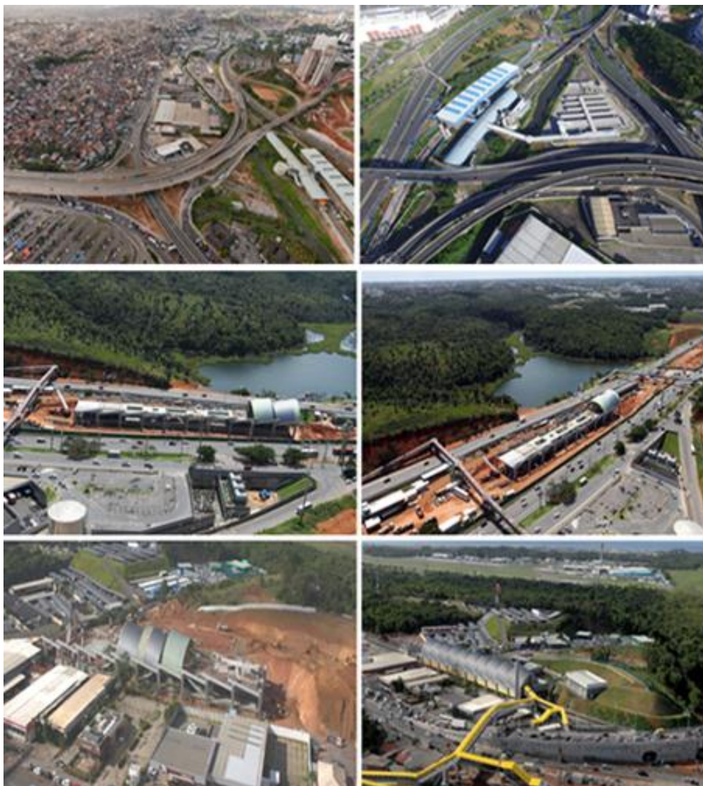
Figura 4: Implementação do Metrô de Salvador – Eventos de Supressão vegetal e Aterramento de rios.
