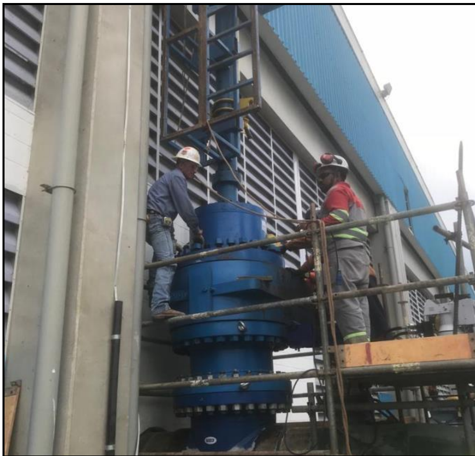
Figura 21 – Instalação da ferramenta de corte sobre a válvula gaveta hidráulica
