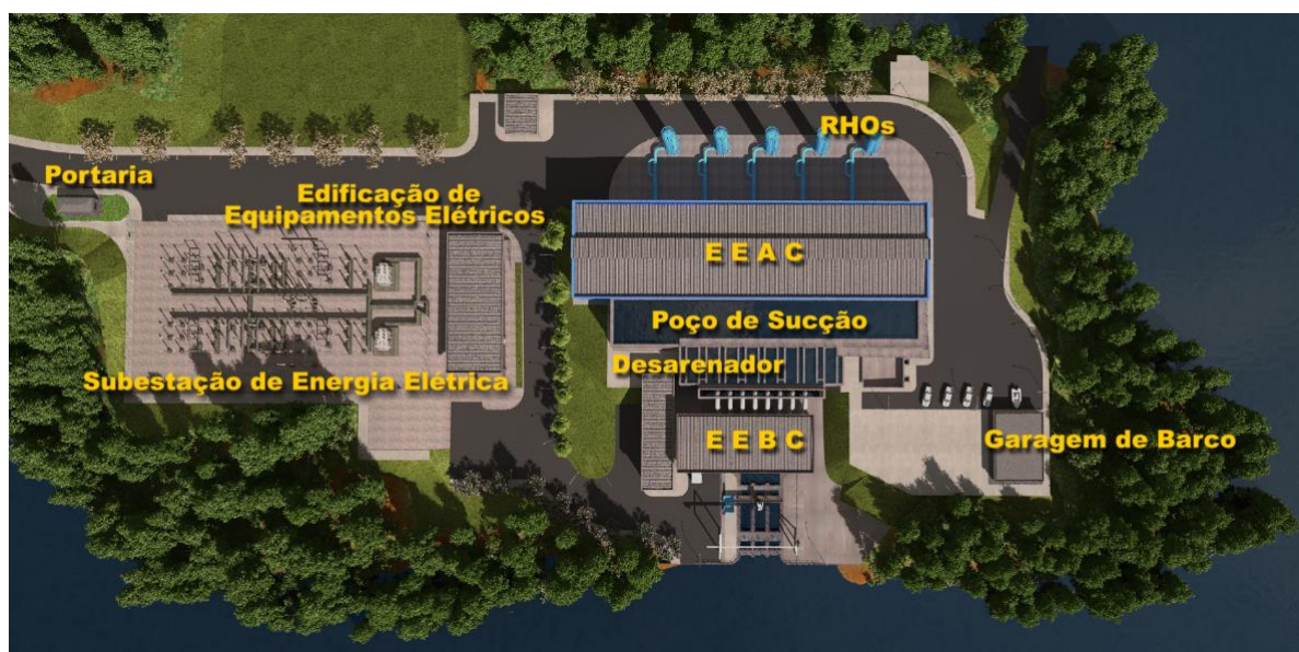
Figura 2 – Identificação das Estruturas de Bombeamento
