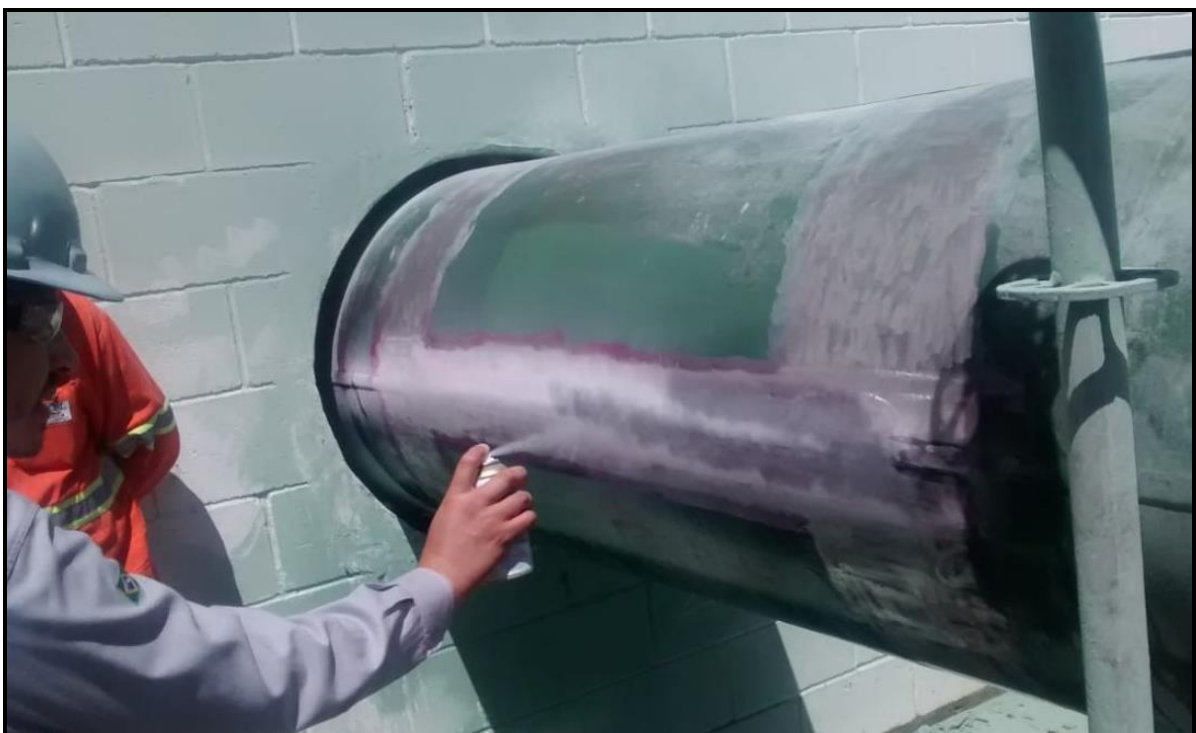
Figura 16 – Preparação e verificação do ponto de instalação do Tee bi-partido
