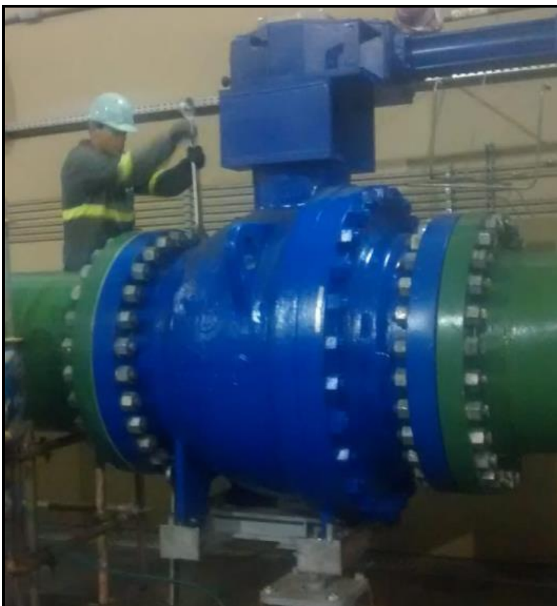
Figura 29 – Reinstalação da nova válvula de bloqueio retrabalhada
