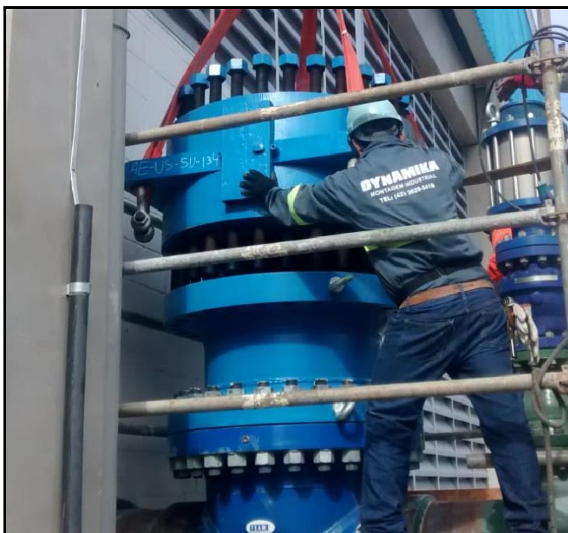
Figura 20 – Instalação da válvula gaveta de acionamento hidráulico para as manobras de troca das ferramentas
