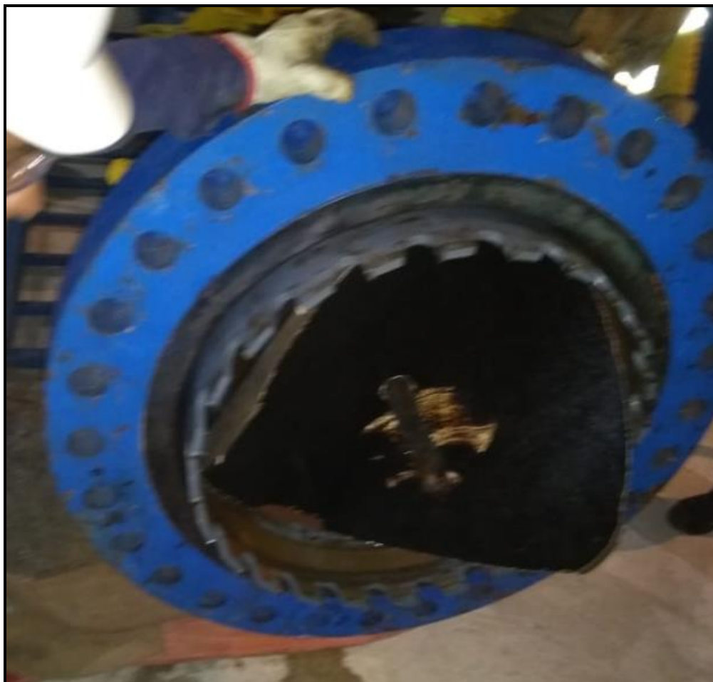
Figura 23 – Detalhe da desmontagem da ferramenta de corte e da broca-guia que traz consigo a peça cortada - chamada no jargão de campo de “bolacha”.
