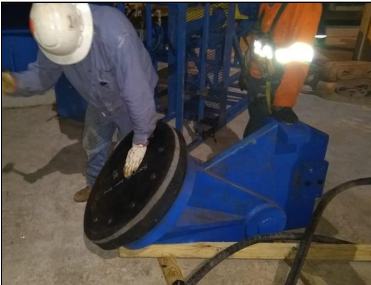
Figura 25 – Preparação do braço articulável que tem a função de inserir a ferramenta e realizar um giro de 90° fazendo com que a borracha solidária à uma placa metálica de ancoragem se fixe uniformemente nas paredes do tubo perfazendo a vedação, análogo à uma lentilha de válvula borboleta
