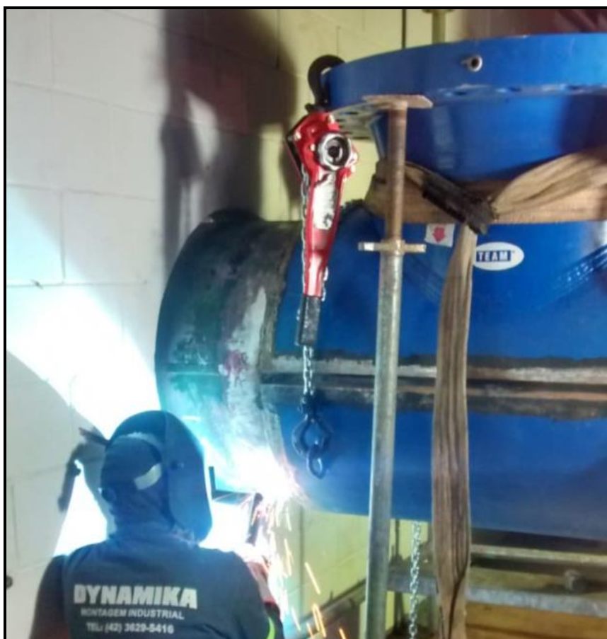
Figura 18 – Processo de soldagem do tee-bipartido
