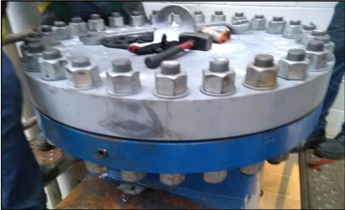
Figura 32 – Finalização do processo de trepanação com a instalação do flange cego definitivo.
