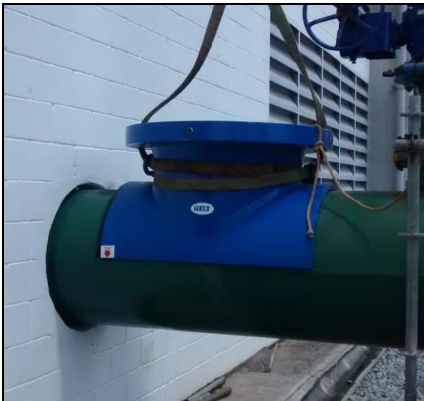
Figura 17 – Detalhe da verificação prévia para instalação do tee-bipartido
