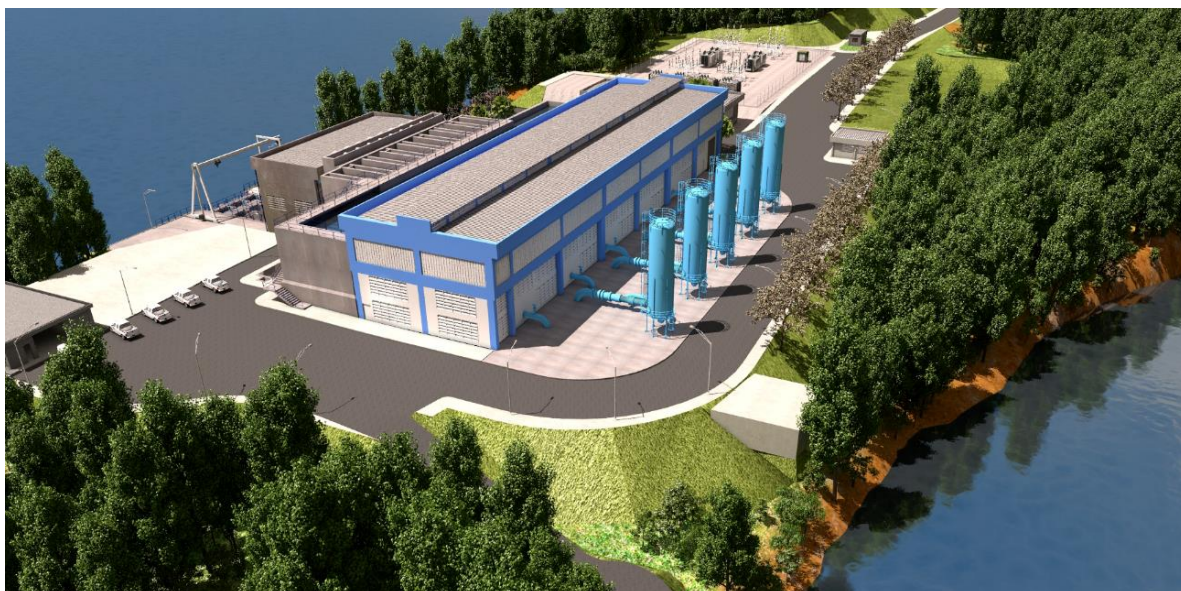
Figura 9 – Vista Geral do Sistema de Captação de Água Bruta e suas sub-unidades
