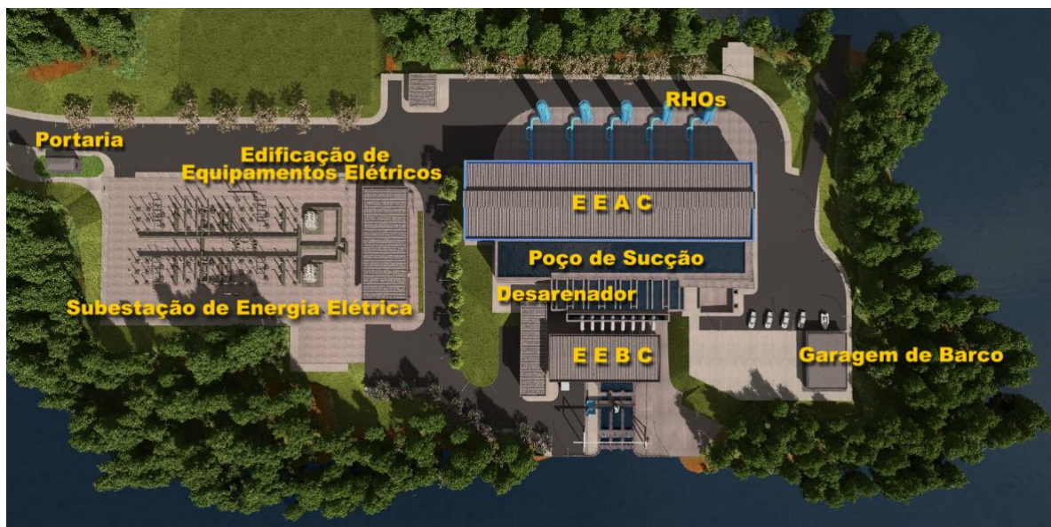
Figura 2 – Identificação das Estruturas de Bombeamento
