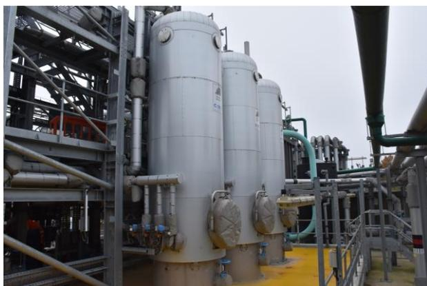
**Figura 3:** Reatores de Hidrólise Térmica dedicada a descarte de lodo ativado da ETE de Long Reach – Thames Water
