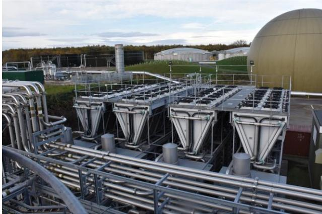
**Figura 20:** Trocadores de Calor para resfriamento do lodo processado em Full Cambi na ETE de Davyhulme operada pela United Utilities
