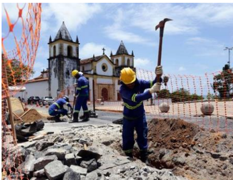
Figura 8 – Foto das obras
