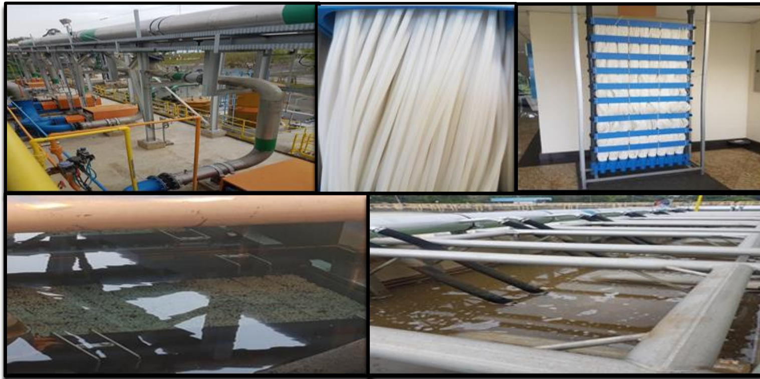
Foto 2-Partes do sistema de membranas Fonte: O autor,2018
