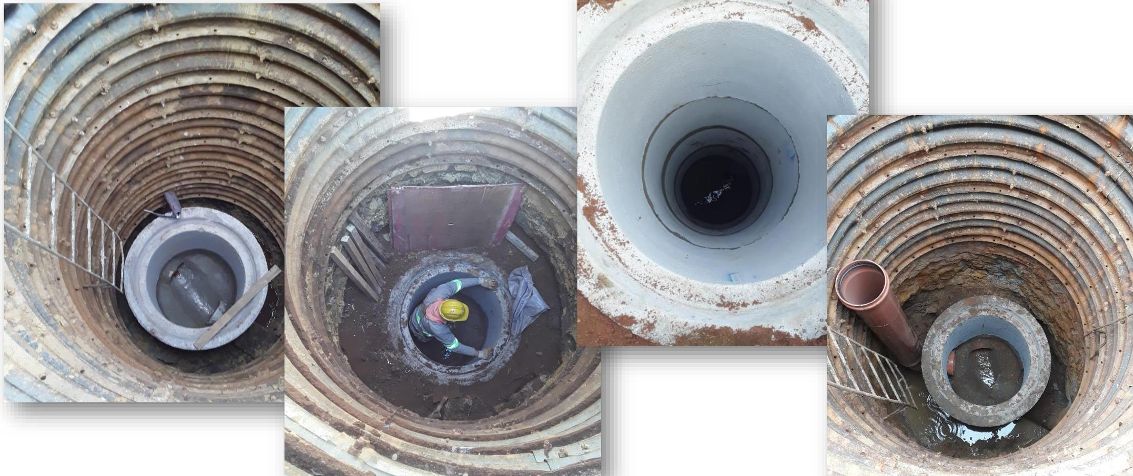
Pvs construídos nos locais de aberturas dos Shafts, com algumas particularidades de execução.
