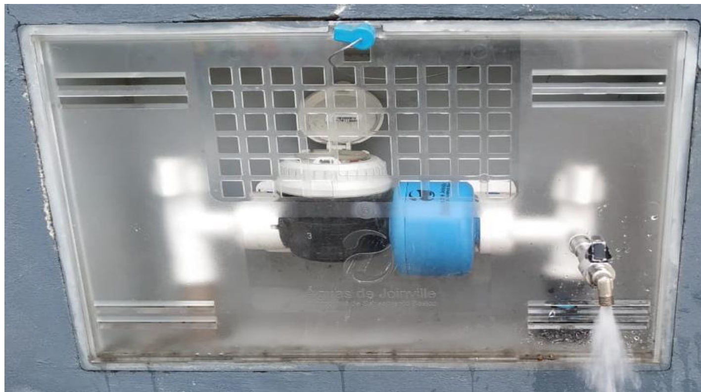
Figura 1: Hidrômetro com filtro retentor de partículas e ferramenta PCQO engatada e aberta.
